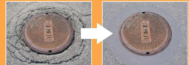
Nivellierung von Kanal- und Schachtdeckel für längere Lebensdauer durch neuartiges Einbausystem; auch bei bestehenden Schachtrahmen anwendbar.
